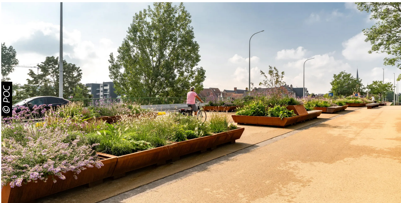
Brug met fysieke scheiding tussen de zones voor voetgangers en fietsers. Bron: Databank Publieke Ruimte, 2025
