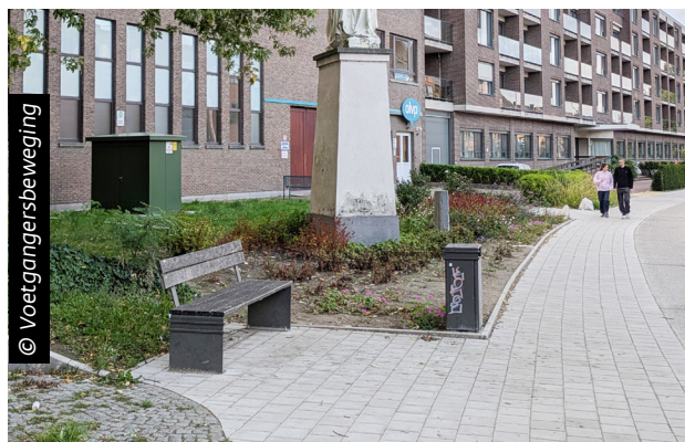
Een zitbank en vuilbak staan buiten de obstakelvrije loopruimte.
