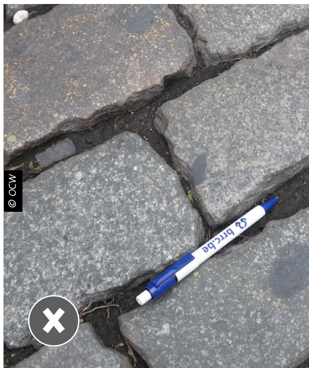
Bestrating met ronde straatkeien en te brede voegen.
