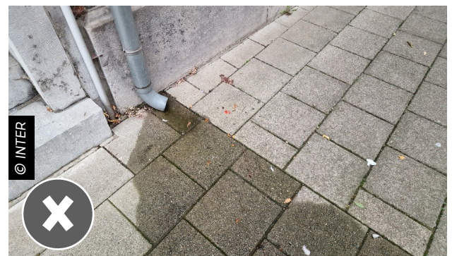
Regenwaterafvoer van gebouwen die over het voetpad loopt.
