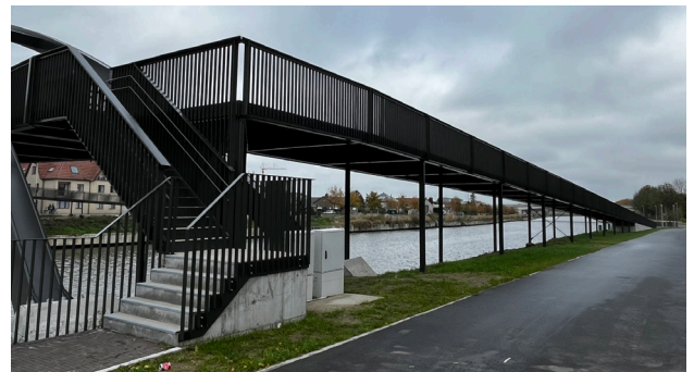
Brug met helling die veel langer is dan de trap.
