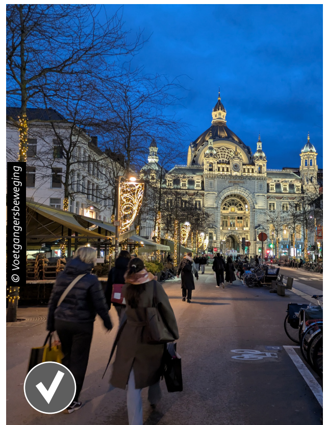
Verlichting die diffuus verspreid is en zonder te hinderen aandacht vestigt op erfgoed.
