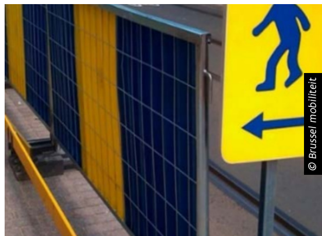
Houten plank onderaan het hekken zorgt voor een natuurlijke gidslijn.
