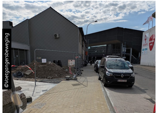
Een afgeschuinde boordsteen voor voertuigen.
