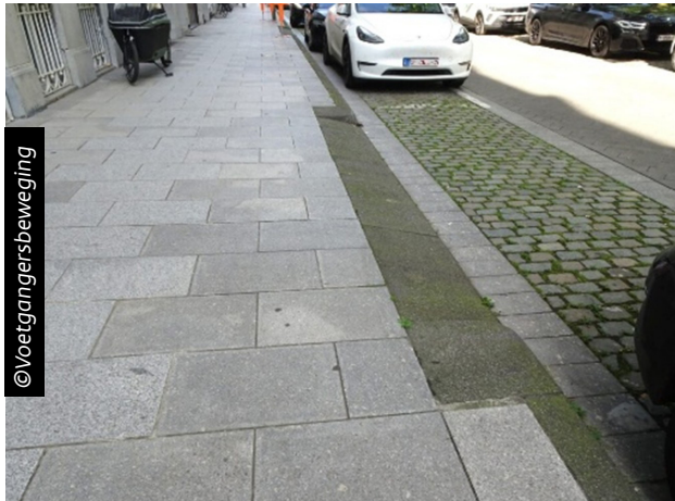
Een geprefabriceerde helling voor voertuigen.
