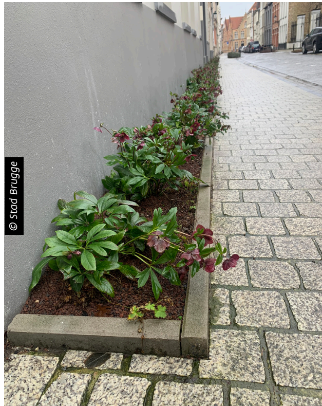
Een opstaande boord van min. 5 cm dient als gidslijn, beschermt de planten en houdt zand binnen het ontharde vlak.
