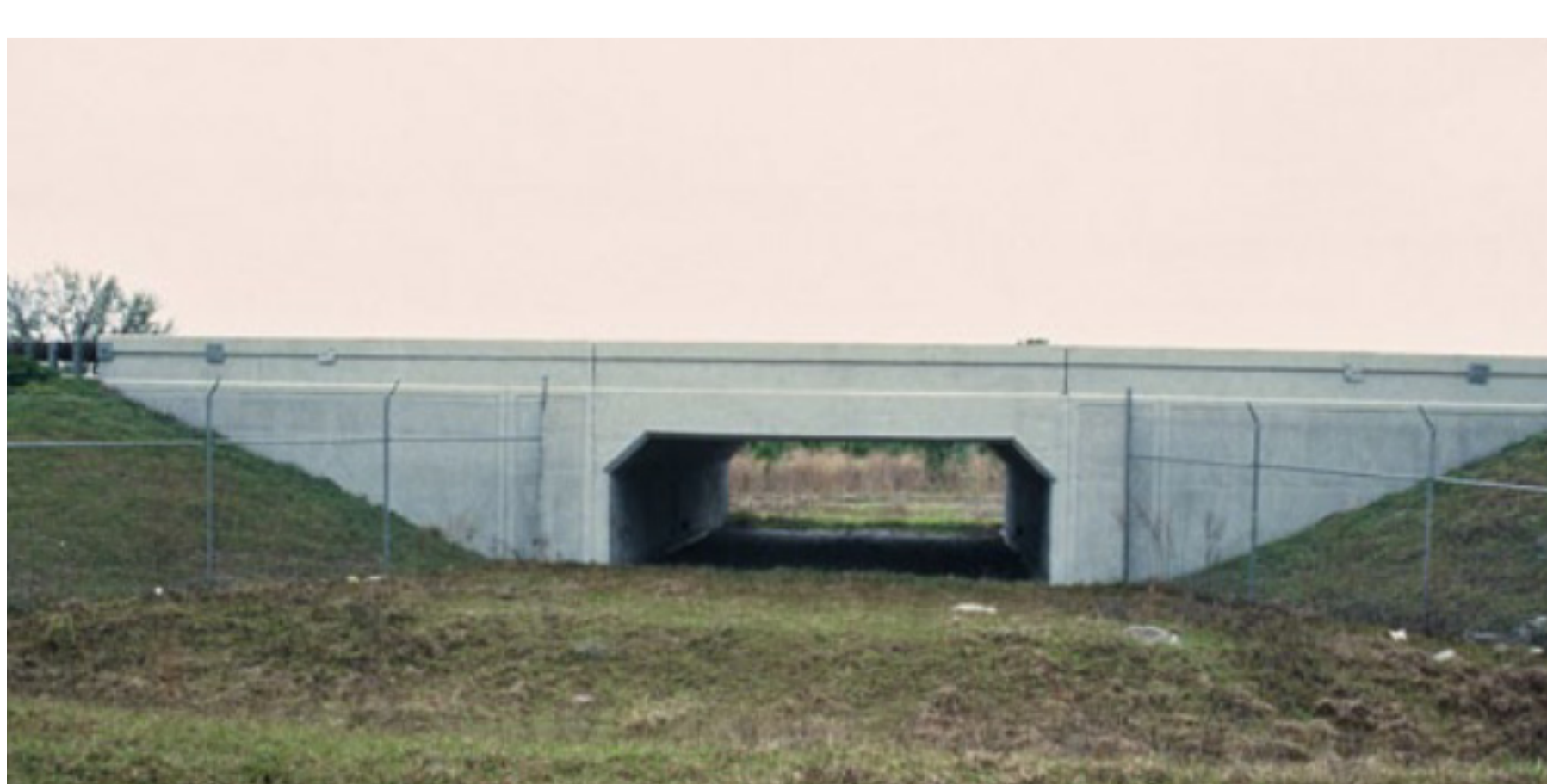
↑ Schematische weergave van een faunatunnel bron: leidraad faunavoorzieningen bij infrastructuur mppo
