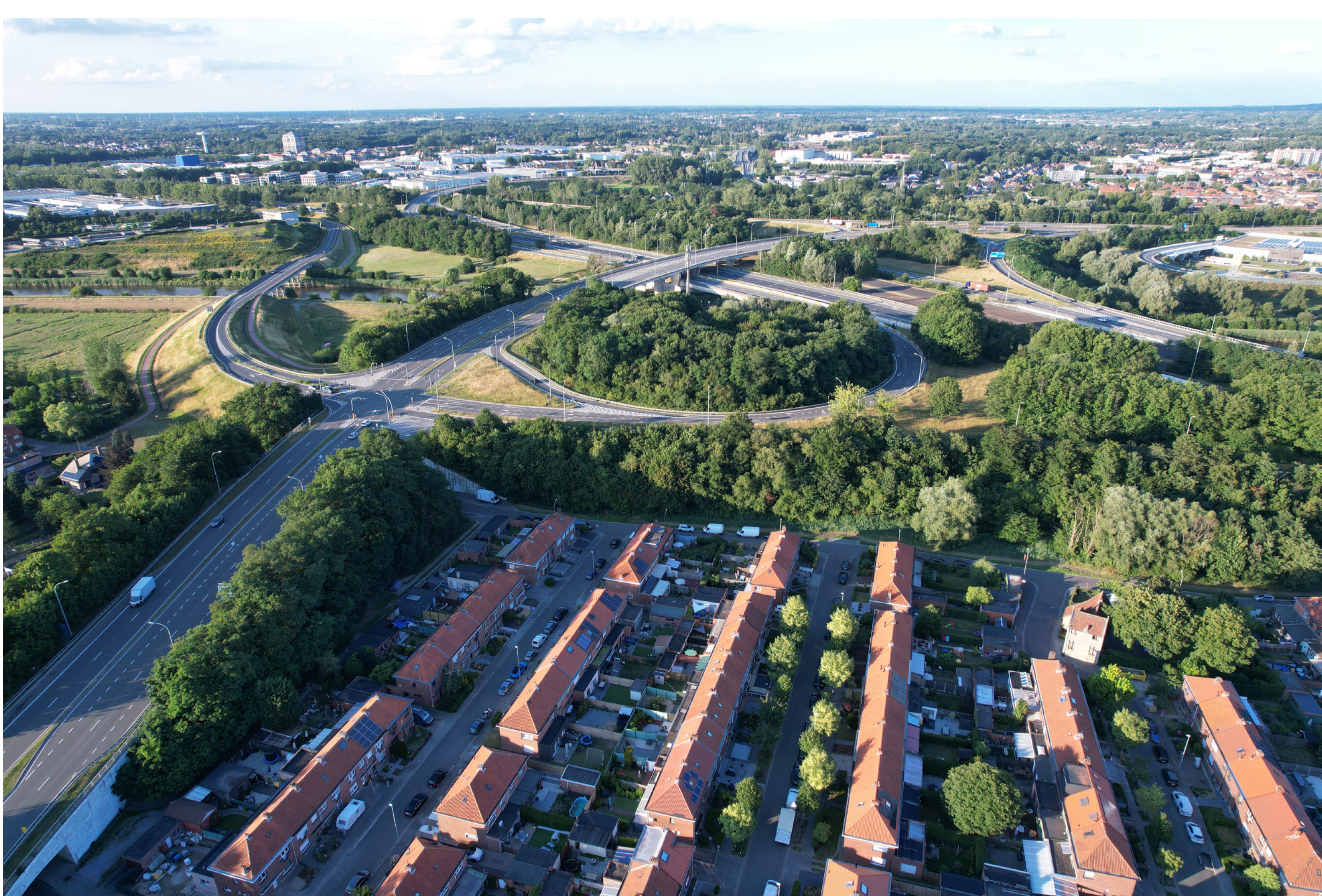
↑ Op- en afrittencomplex Mechelen Noord – Bestaande toestand
