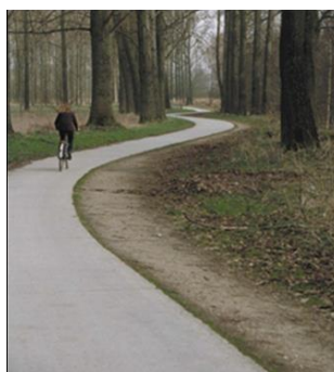
Foto 4.6 Fietspad in cementbetonverharding
