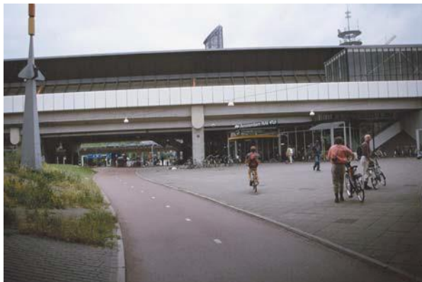
Foto 2.7: Fietsroute met tunnel onder station - Amsterdam
