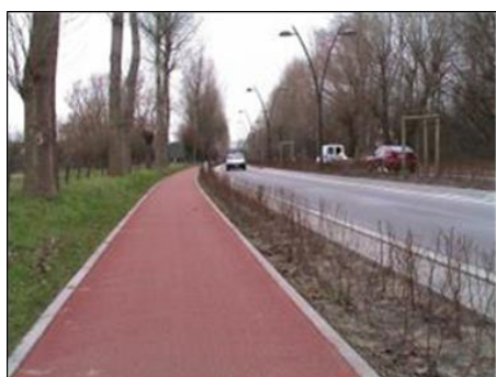
Foto 4.5 Fietspad in bitumineuze verharding
