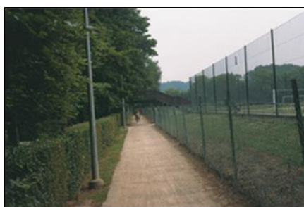
Foto 4.8 Fietspad in halfverharding
