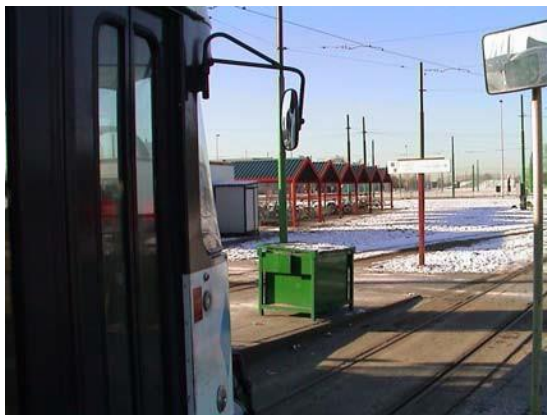
Foto 4.59 Fietsenstalling tramhalte Antwerpen Linkeroever
