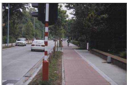
Foto 4.7 Fietspad in bestrating met betonstraatstenen
