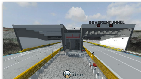
BIM in de renovatie van de Beverentunnel
