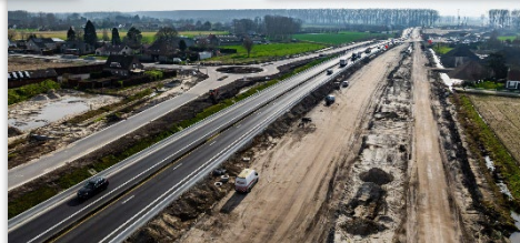
Ombouw van de N49 tussen Damme en Maldegem
