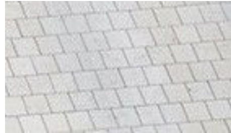
Voetpad Betonstraatsteen: coherentie in de Antwerpse boulevard: Lichtgrijze kleur
