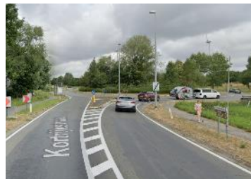
Figuur 106: zuidoostelijke tak
