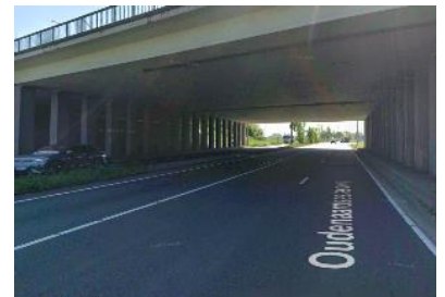
Figuur 84: Onder brug E17 richting rotonde
