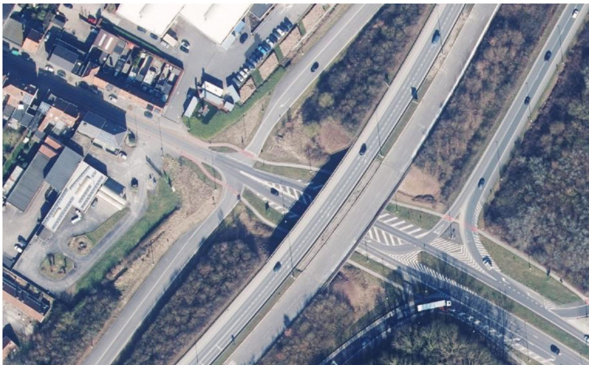
Figuur 75: Aansluiting afrit R8 (afrit 3a) en toerit E17 (naar zuiden)
