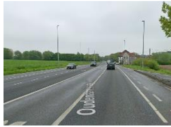
Figuur 100: N8 richting N391 langsheen bebouwing
