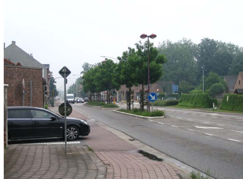
Figuur 28: Bestaande verlichting in doortocht Boutersem
