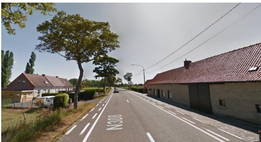
Figuur 3-7: bestaand wegenisprofiel in de deelzone (grens Poperinge/Ieper - Brandhoek) (bron streetview)
