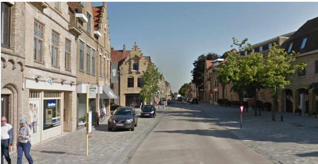
Figuur 5-9: Rijweg in uitgewassen beton (Oostendestraat te Diksmuide)
