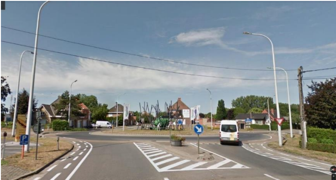
Figuur 3-5: bestaand rotonde N308 – Europalaan - Oostlaan (bron streetview)
