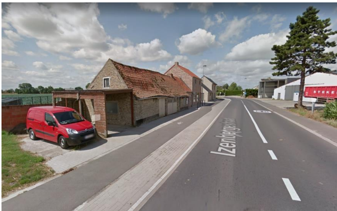
Figuur 5-12: Combinatie fietspad en rijweg in asfalt met veiligheidsstrook in betonstraatstenen (Izenbergestraat Alveringem).
