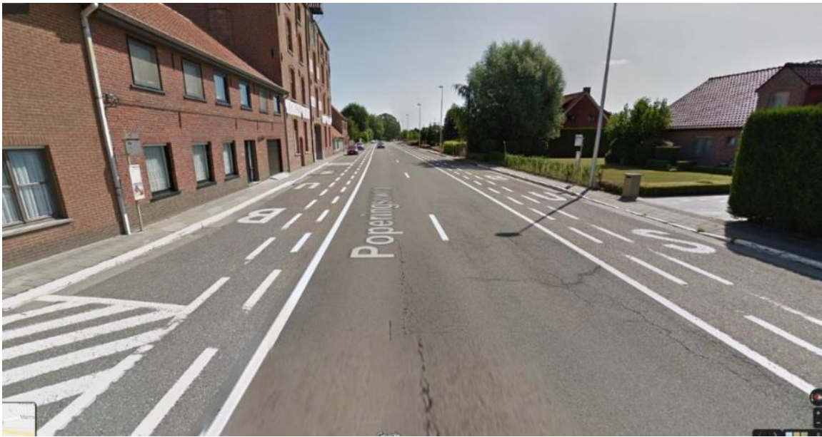
Figuur 3-29: bushalte Casselstraat (bron streetview)
