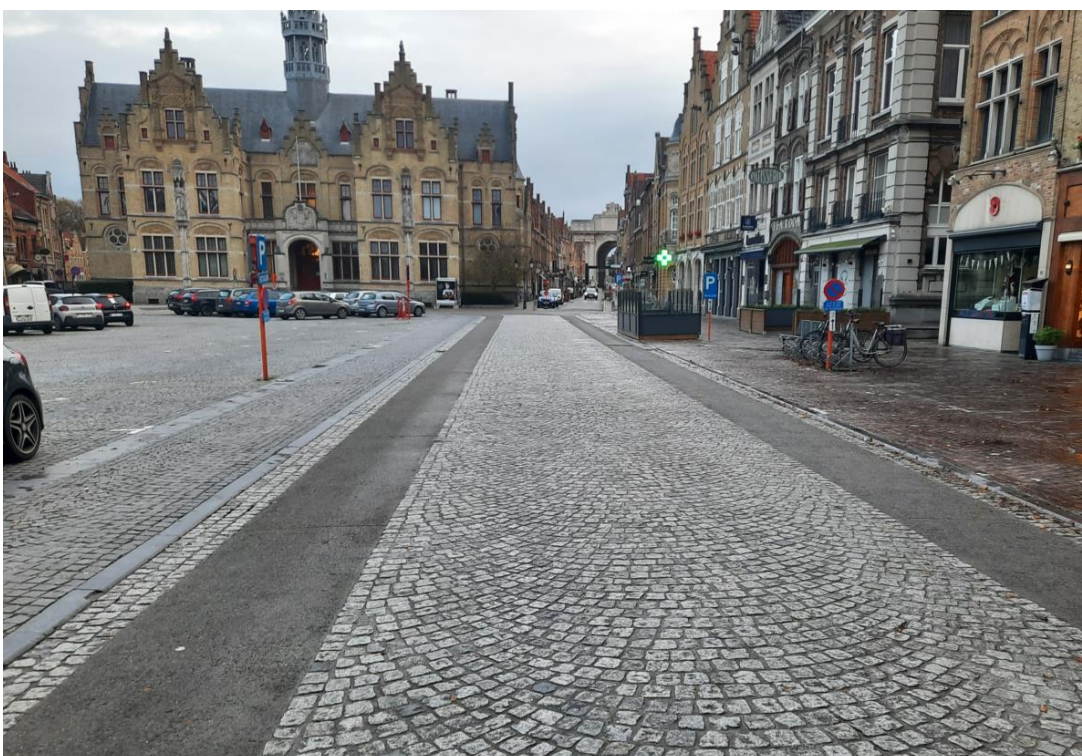
Figuur 5-10: Fietssuggestiestroken in uitgewassen beton en rijweg in mozaïekkeien (Markt Ieper)
