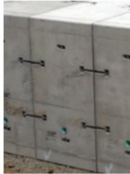
Figuur 13-37-2: mechanische uitwendige koppeling met ingestorte krachtverdelingsplaten (verbinding door draadstang, krachtoverdrachtplaten, rondellen en moeren)
