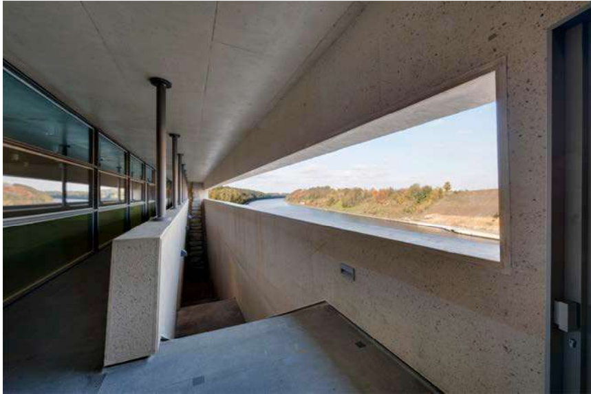
Gallerij met kolommenrij en betonnen wand, Brug Riemst
