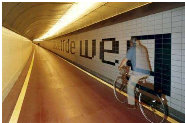
Tegelbekleding wanden, Beneluxtunnel, Nederland
