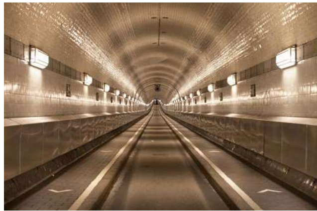
Tegelbekleding wanden, Oude ELbetunnel, Hamburg
