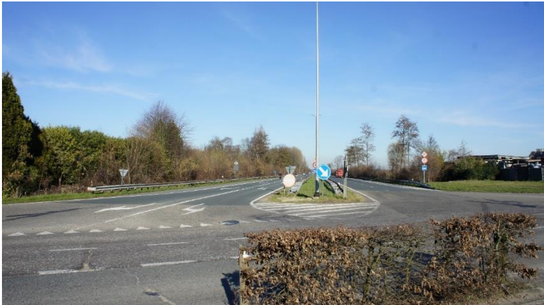
Figuur 5-2 Einde van de N171 ter hoogte van de Eikenstraat
