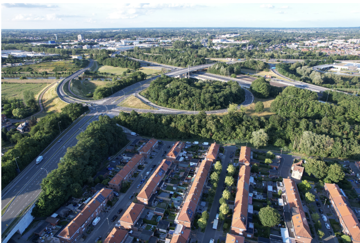
Figuur 1: op- en afrittencomplex te Battel, bestaande toestand
