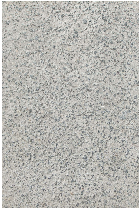
Chemisch uitgewassen doorgaand gewapend beton
