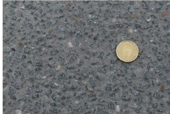
Tweelaags doorgaand chemisch uitgewassen beton
