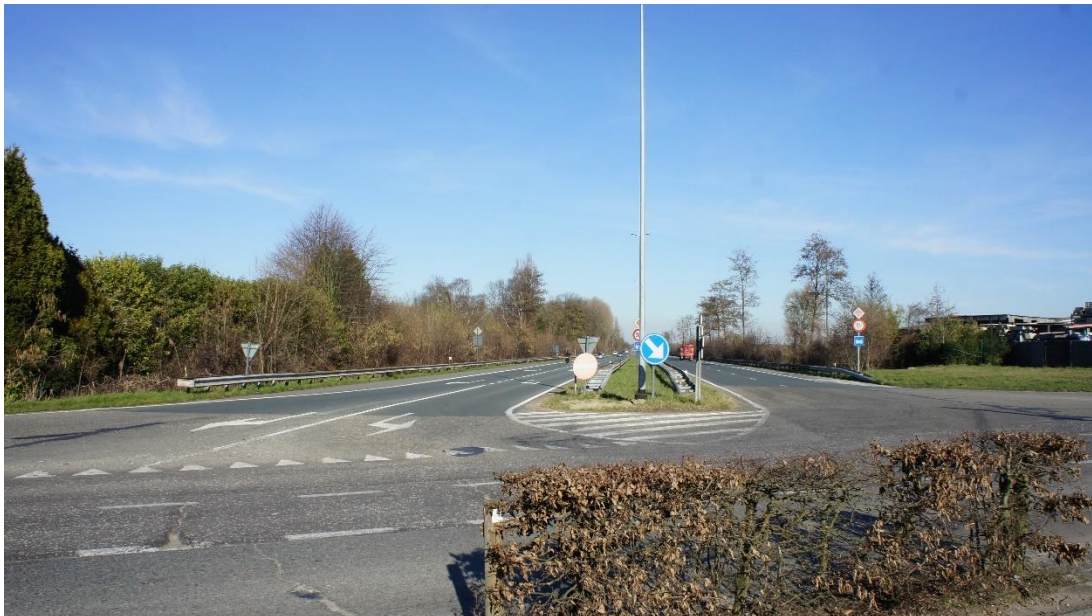
Figuur 6-2 Einde van de N171 ter hoogte van de Eikenstraat
