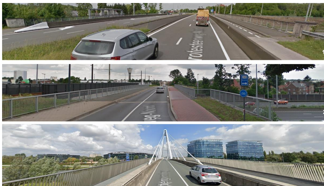
Figuur 3-4. Infrastructuur van de bruggen over de vaart (van boven naar beneden: N60, Heerweg-Noord en Ottergembrug)
