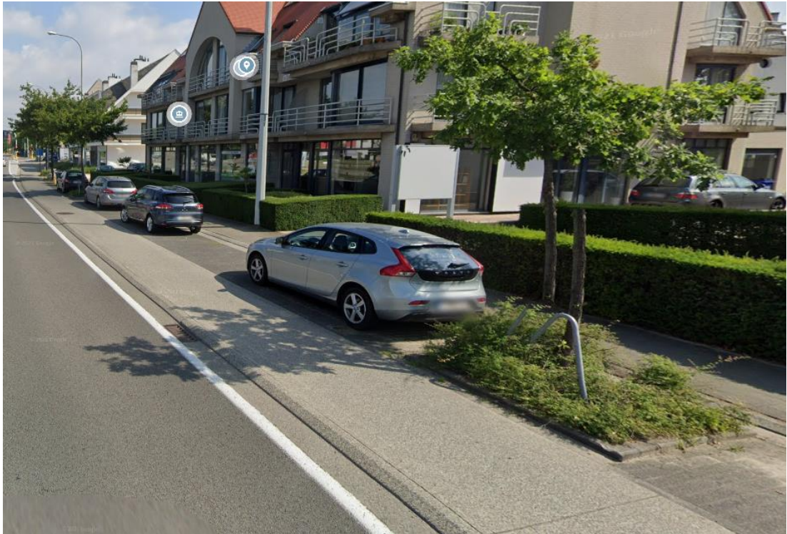
Figuur 3-32: Fietsinfrastructuur tussen geparkeerde auto's en de N60
