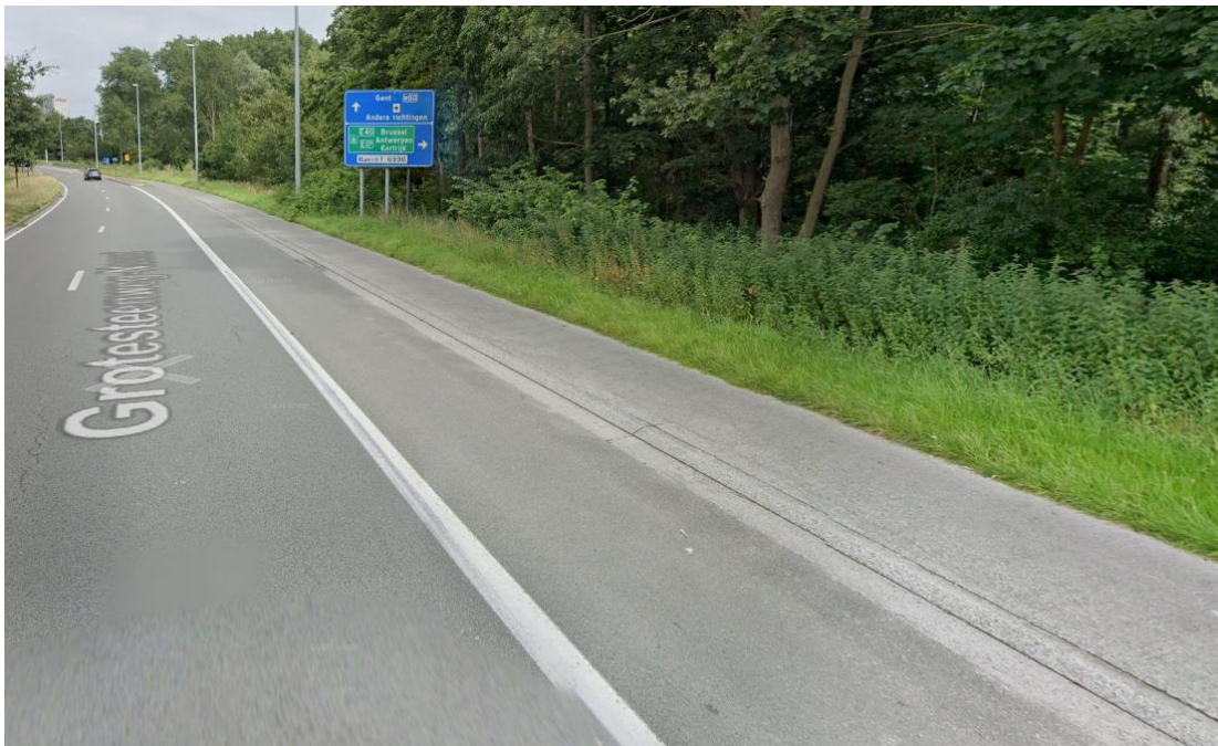
Figuur 3-27: Voetgangers en fietsers delen de Scaarse ruimte aan de voet van de brug van de N60 ten noorde van de Ovonde richting Stad Gent
