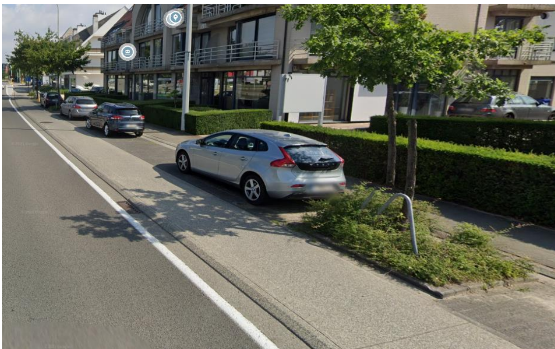
Figuur 3-29: Mogelijk conflictpunt tussen fietsers en openslaande deuren
