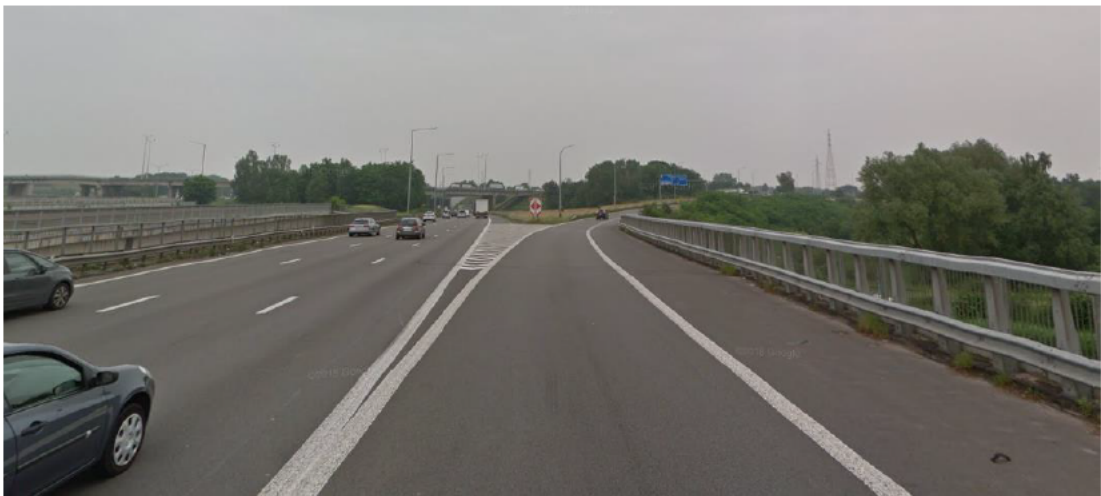
Figuur 98: E19, Mechelen-Noord, afrit E19 vanuit Brussel richting N16/R6
