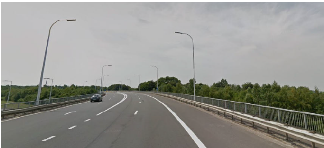
Figuur 101: R6 - splitsing linkse oprit E19 Brussel en N16
