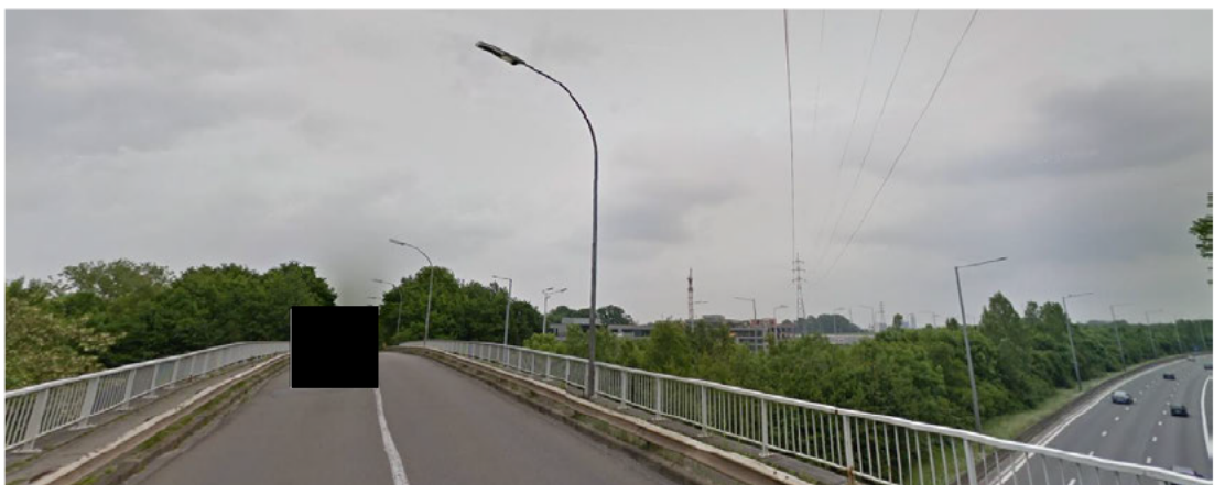
Figuur 115: Blarenberglaan brug over E19
