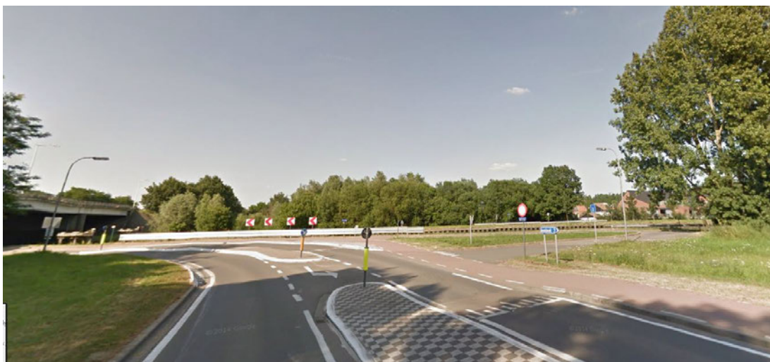
Figuur 123: Aansluiting Uilmolenweg (N109) met de Stuivenbergvaart
