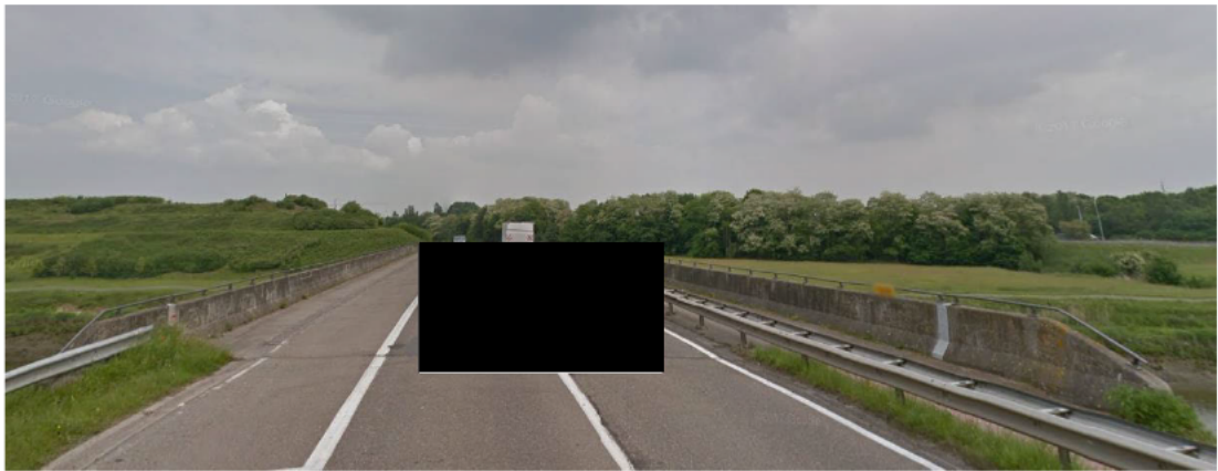
Figuur 113: Blarenberglaan - Brug over Dijke
