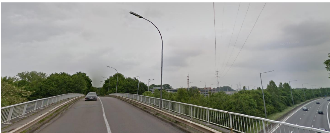
Figuur 115: Blarenberglaan brug over E19
