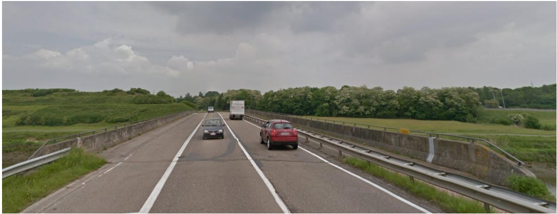
Figuur 113: Blarenberglaan - Brug over Dijle
