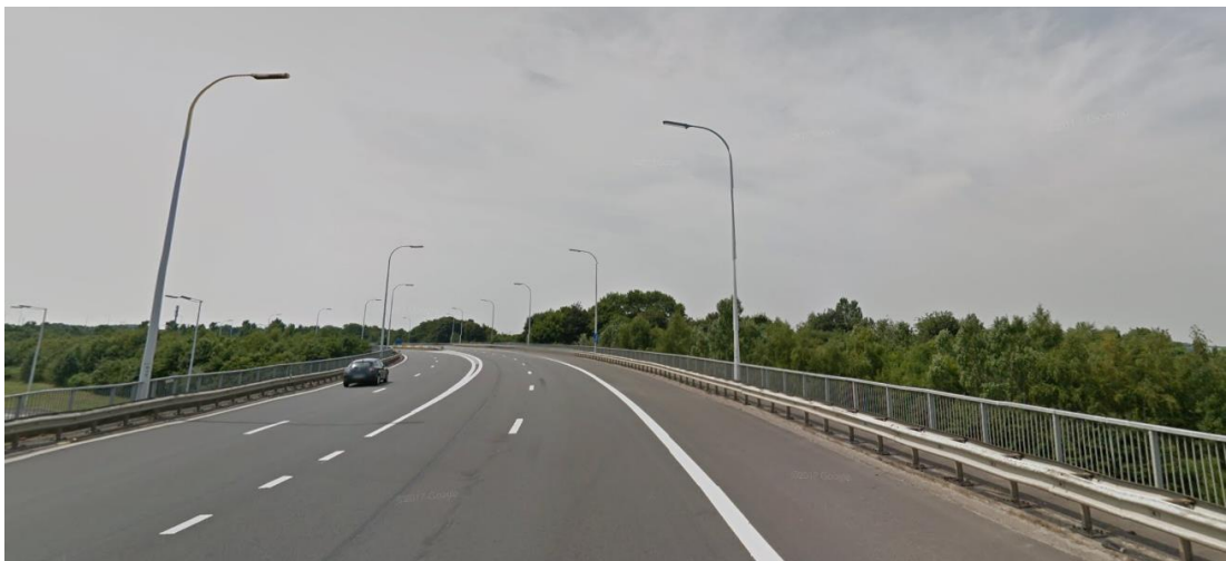
Figuur 101: R6 - splitsing linkse oprit E9 Brussel en N16
