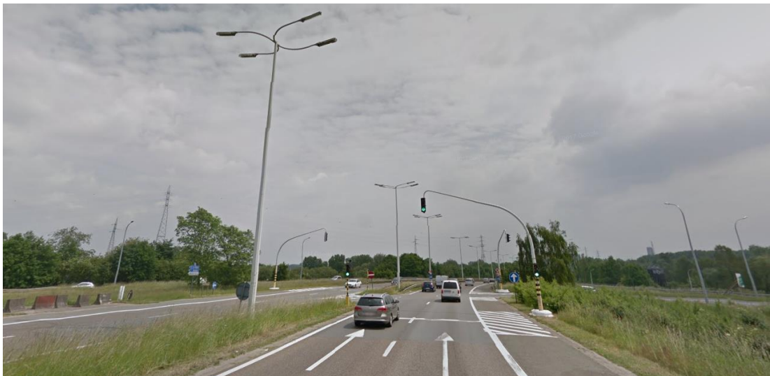
Figuur 108: Genstesteenweg (N16) - kruispunt met op- en afrit E19
