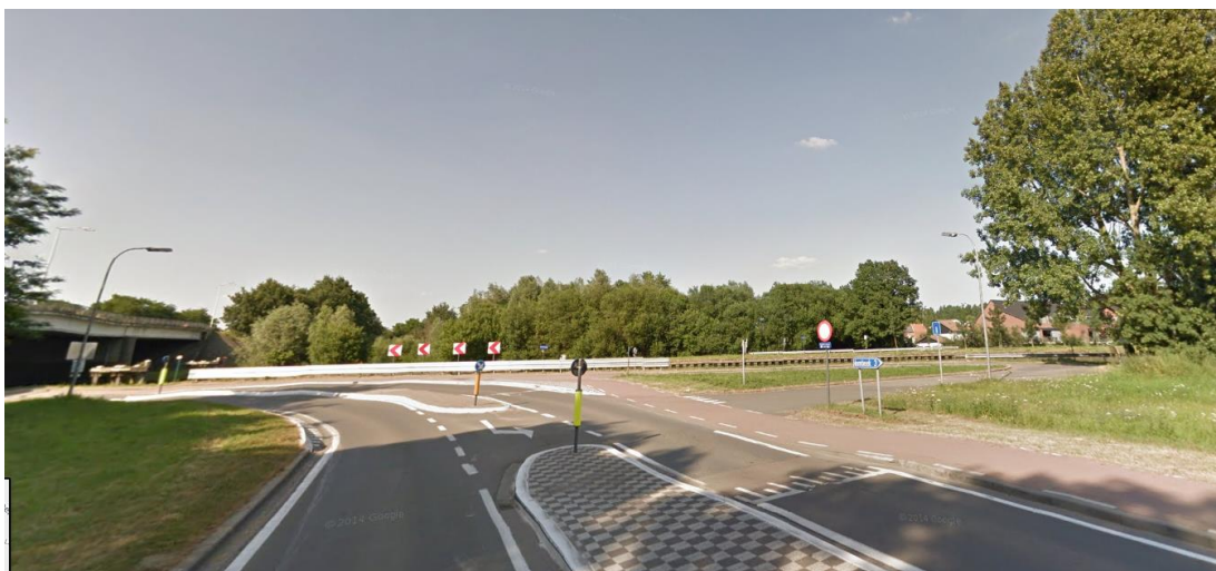
Figuur 123: Aansluiting Uilmolenweg (N109) met de Stuivenbergvaart
