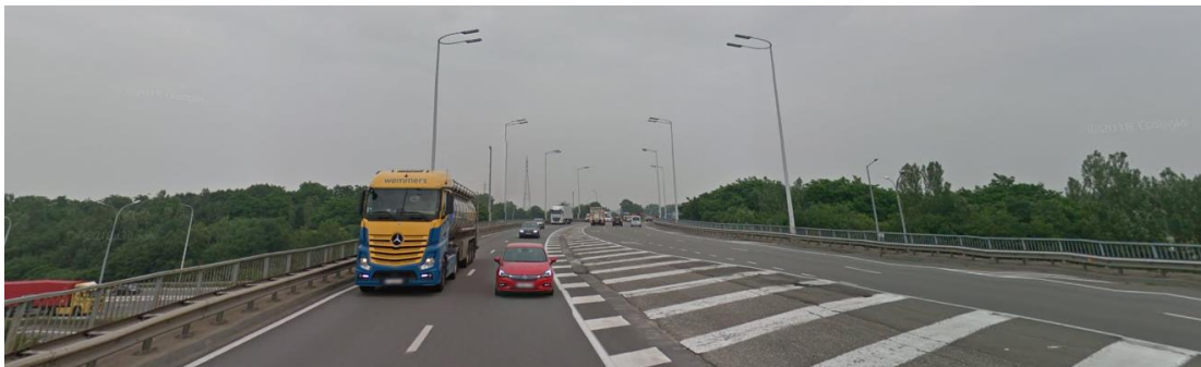
Figuur 107: Genstesteenweg (N16) - Brug over E19
