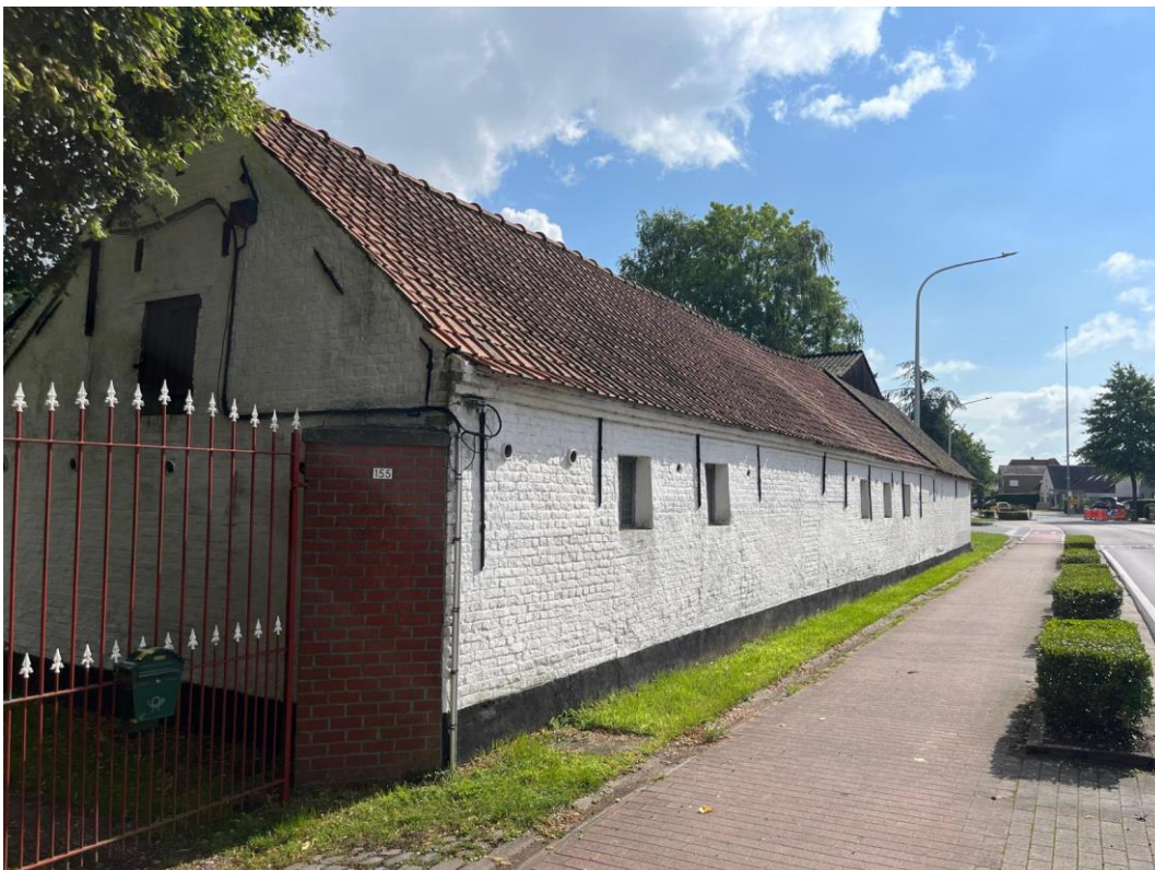
Noodzakelijk te onteigenen gebouw in functie van aanleggen linksafslagstrook Laarnebaan
