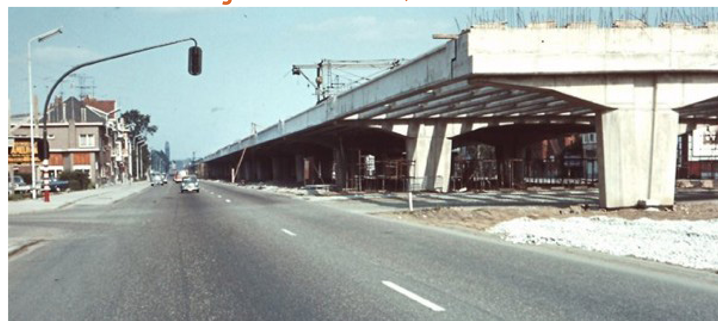
Viaduct van Wilrijk in aanbouw, 1969
