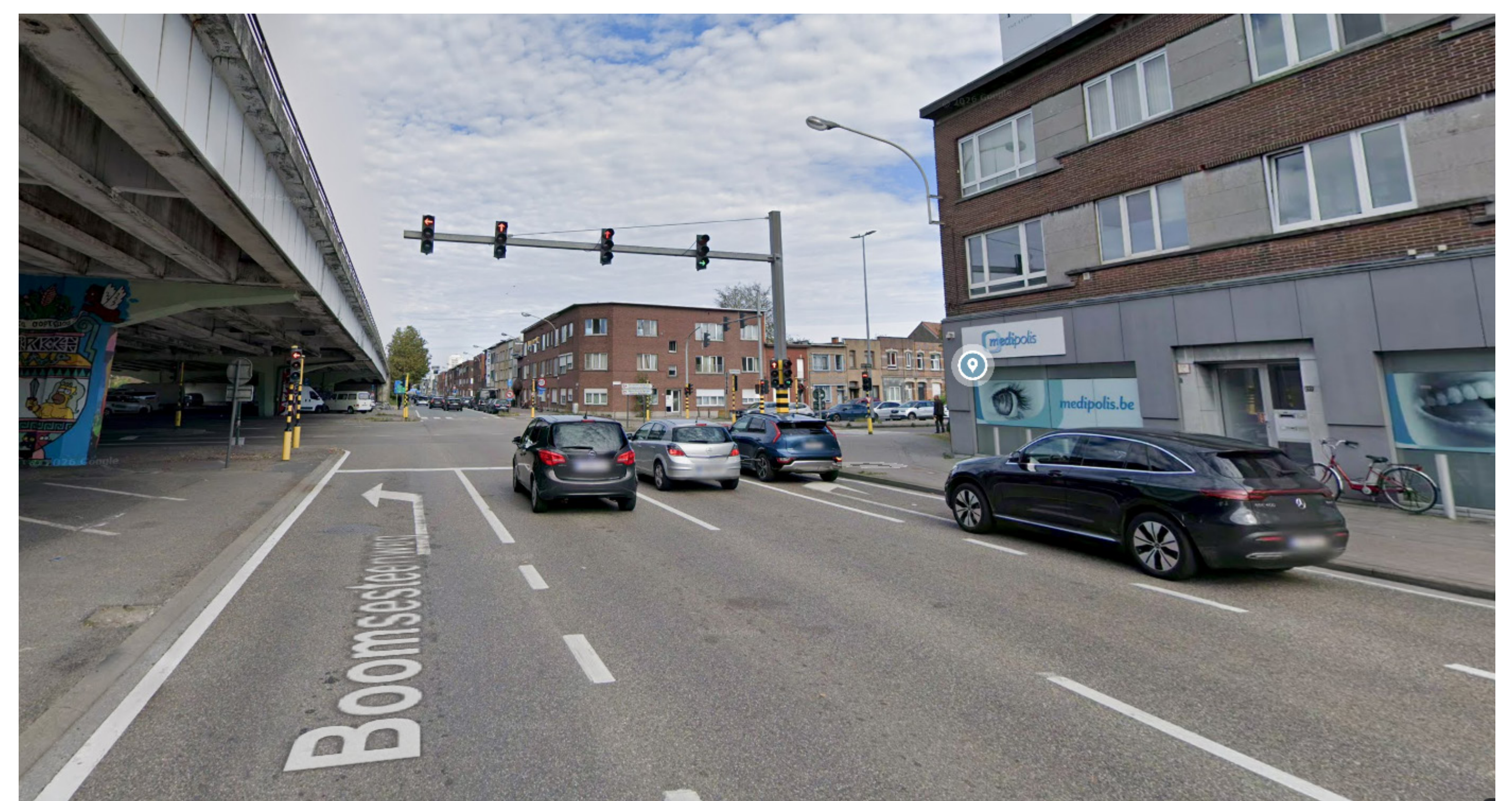
© Team Intendant, A12 Viaduct Wilrijk - Eindrapport Verkennend Traject, 2026
