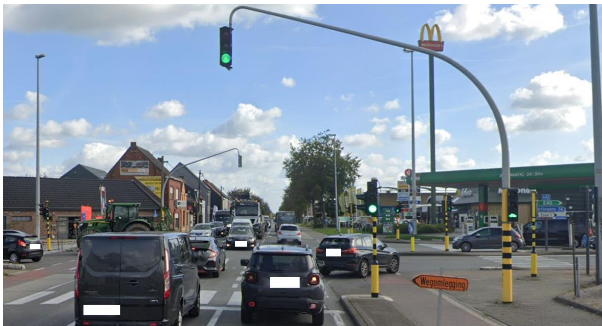
Figuur 35 De grote boogpaal met het fietserslicht staat rechts van het fietspad; de lantaarns voor motorvoertuigen en voetgangers links ervan [Wetteren N9 x N42]
