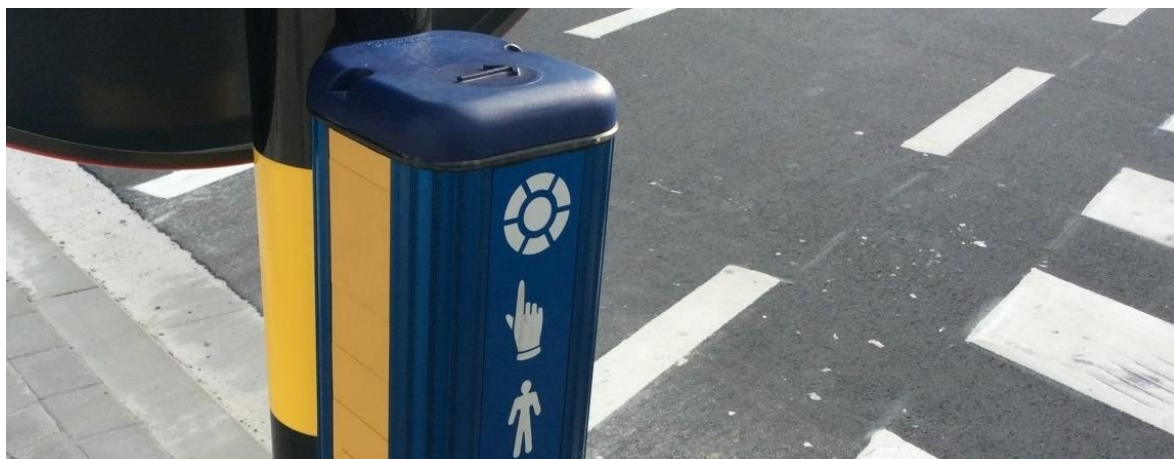
Figuur 124 Voorbeeld van de bovenzijde van een blindendrukknop, waar een voelbare pijl in de oversteekrichting wijst
