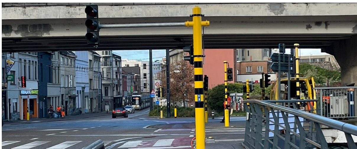
Figuur 36 De lantaarn hangt tussen fietspad en rijbaan, maar de seinpaal staat ver van de rijbaan [AWV; Keizerpoort]
