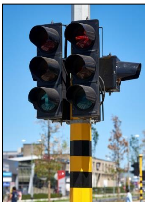
Figuur 30 Driekleurige pijllichten
