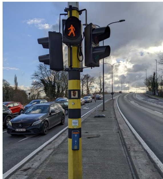
Figuur 68 Oranjegeel knipperlicht met voetganger-silhouet
