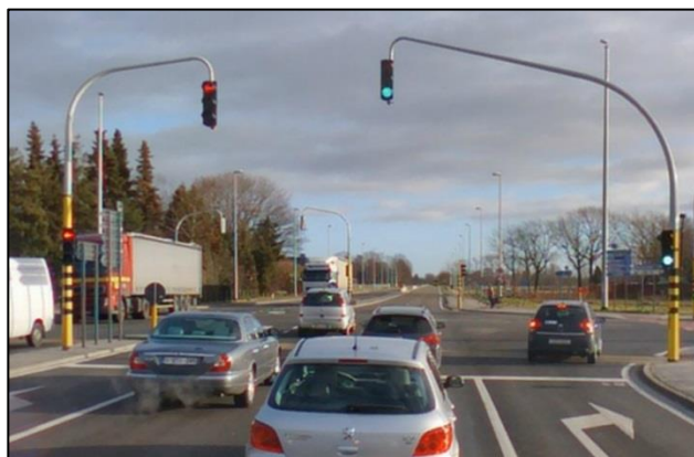
Figuur 31 Volle lens in combinatie met een driekleurige pijllicht linksaf
