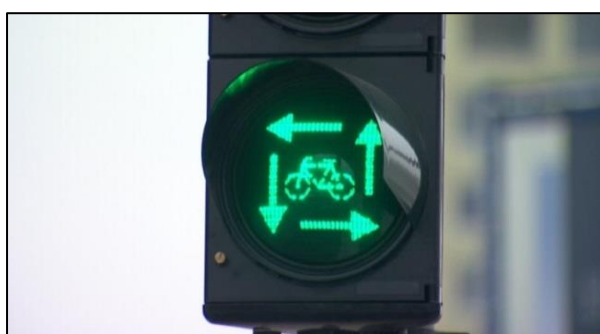
Figuur 61 Voorbeeld van een vierkant-groen-verkeerslicht
