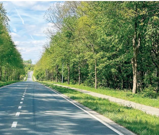
De N36 in Kluisbergen (70 km/u): een mooi voorbeeld van een wegprofiel met vrijliggende fietspaden en ruimte voor bomen. | © Clif Buyze
