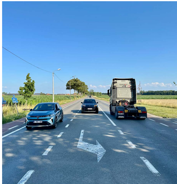
De N8 vormt vandaag al een belangrijke verkeersas voor zowel lokaal als regionaal verkeer.
