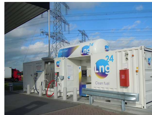
LNG tankstation, Zwolle
