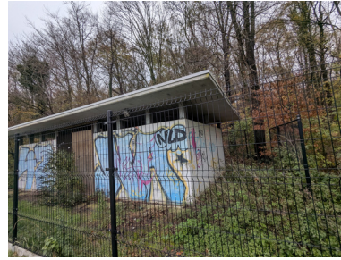
c. afgesloten toiletgebouw
