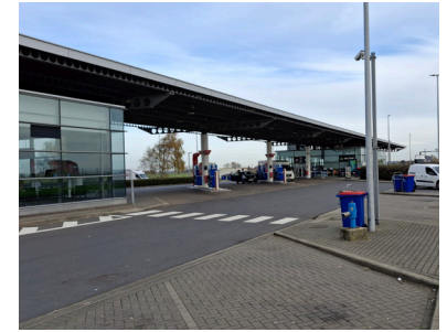
e. tankstation parallel aan de snelweg
