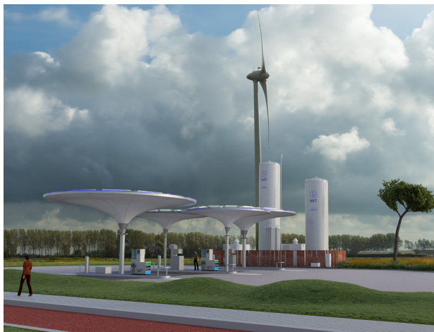
Tankstation NXT, Alkmaar (LNG, GTL, CO 2 , biodiesel, elektriciteit)
