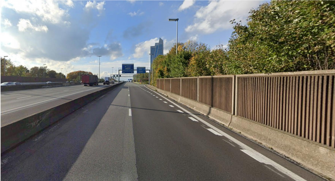
Figuur 4-7: Beeld van de weginfrastructuur t.h.v. aansluitingscomplex Sint-Denijs-Westrem richting Oostende
