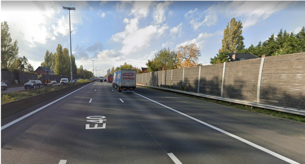
Figuur 4-1: Beeld van de weginfrastructuur op de noordelijke weghelft van de hoofdbaan van de E40
