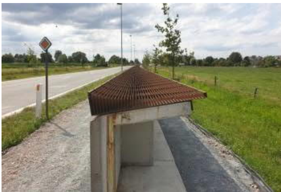
Figuur 3-8: Diffractor gelijk met de weg (bron:www.4silence.com)
