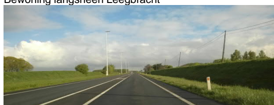
Verzonken ligging N42 met taluds aan beide zijden
