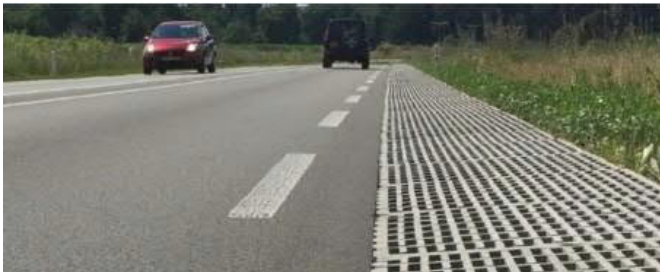
Figuur 3-8: Diffractor gelijk met de weg (bron:www.4silence.com)
