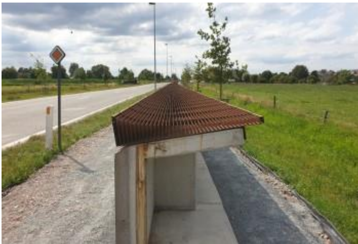
Figuur 4-6: Diffractor gemonteerd op een laag absorberend geluidsscherm (bron:www.4silence.com)
