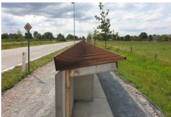
Figuur 2-14: Diffractor gemonteerd op een laag absorberend geluidsscherm (bron:www.4silence.com)
