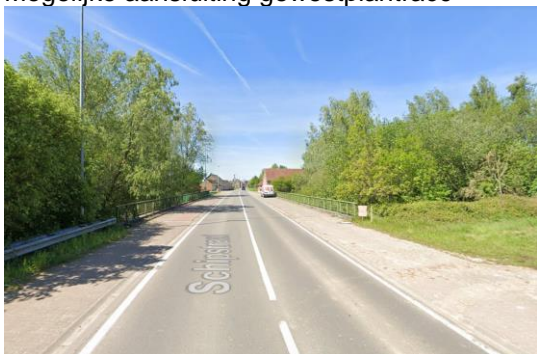
Brug Schipstraat thv gewestplantracé Figuur 5-1: Fotoreportage
