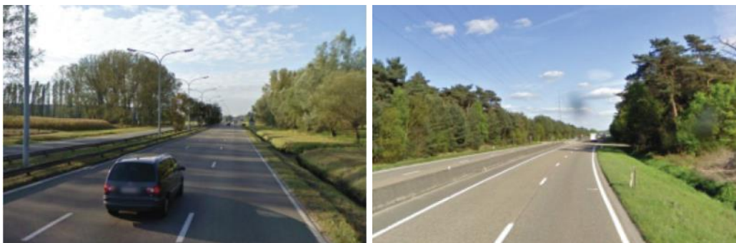
Figuur 5-2: Voorbeeld verlichting links overgangszone A12 thv Willebroek – rechts niet verlichte zone N71 Mol
