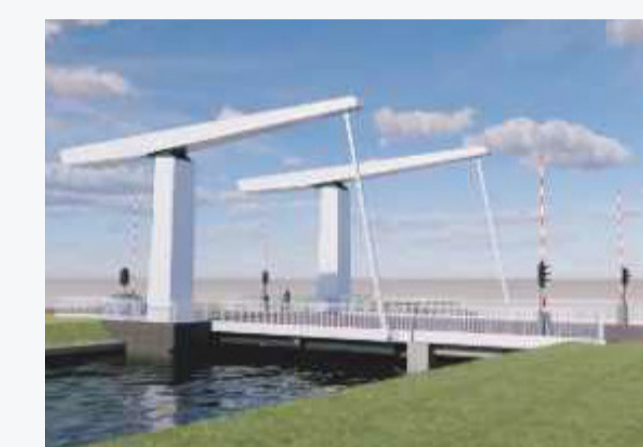
➤ een ophaalbrug (waarbij het brugdek kantelt)
