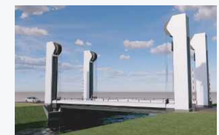
↪ een hefbrug (waarbij het brugdek omhoog wordt gehesen)
