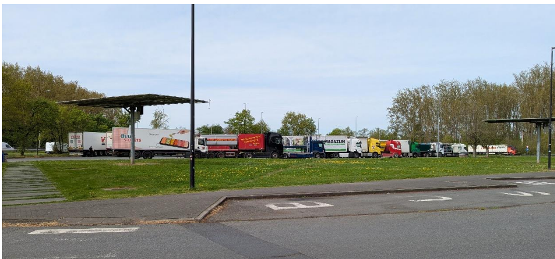
Figuur 3.66: Zonneboilers op site Drongen richting Oostende (bron: Tractebel 17/04/2025)
