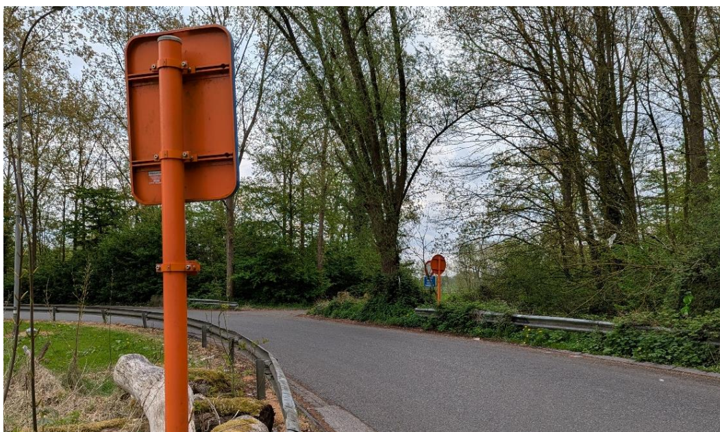
Figuur 3.40: Mogelijk oneigenlijk gebruik aanliggend wegennet op site Drongen richting Brussel (bron: Tractebel 15/04/2025)
