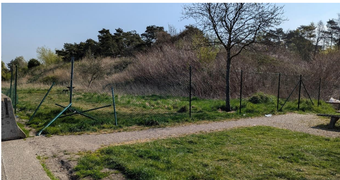
Figuur 3.64: Beschadigd hekwerk op site Brecht (bron: Tractebel 09/04/2025)
