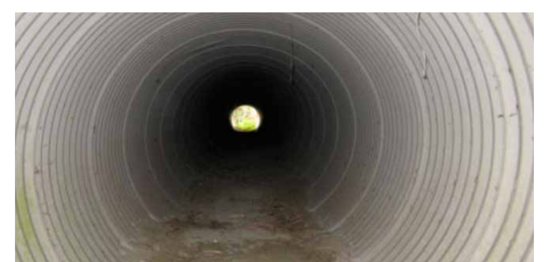
↑ Schematische weergave van een kleine faunatunnel bron: leidraad faunavoorzieningen bij infrastructuur mjpo
