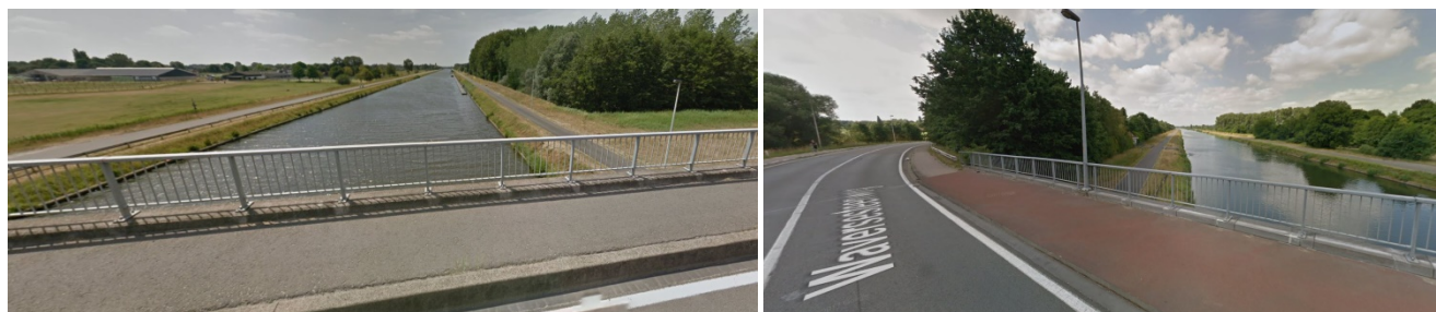
Figuur 28: Aanlegsteiger langs Netekanaal - Netekanaal van op bruggen N10 en N108
