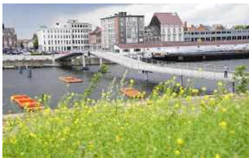
Bataviabrug, Gent - groter vaarvenster zonder onderbreking overgang
