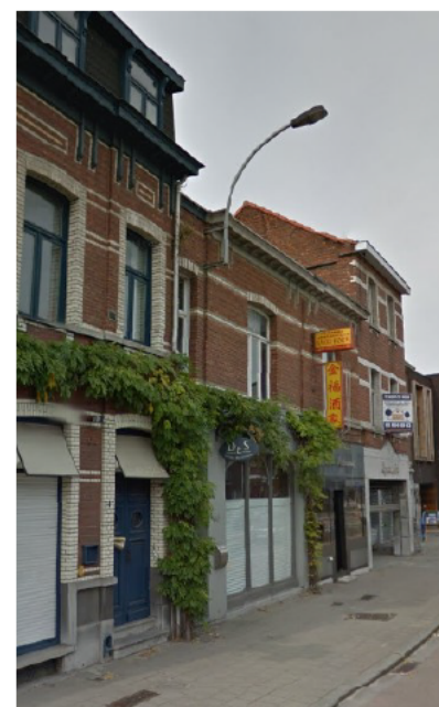
Verlichting aan gevel
