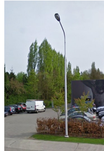
2: Zijde Ekeren. In de eerder besproken handel – en horecazone zijn de armaturen bevestigd aan de gevels.
