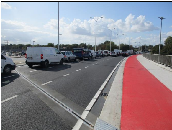
De rijstroken stadinwaarts op de brug over de Ring zijn volledig vernieuwd.
