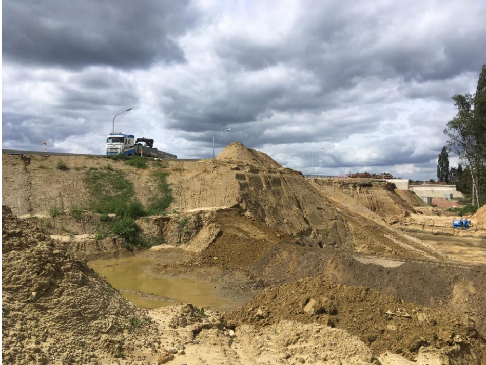
Grondwerk voor het ophogen van de weg naar de brug over het Albertkanaal.
