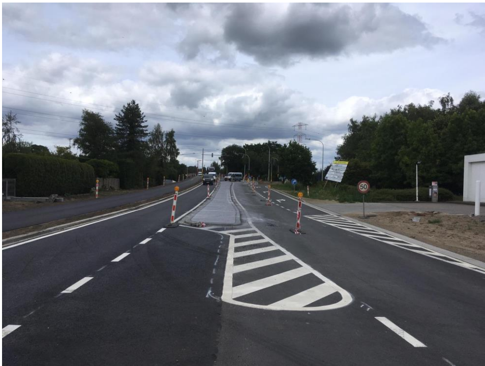
Het nieuwe wegdek tussen de brug over de E313 en de Kanaalstraat ligt al klaar.
