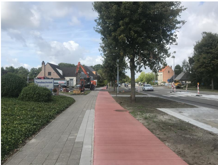
Nieuw fietspad ter hoogte van Rooibos.
